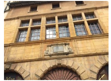
4 – Façade l'ancienne mairie
