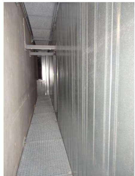
18 - Vide technique entre la façade et les murs de bétons du bâtiment pour garantir température et humidité constante.
