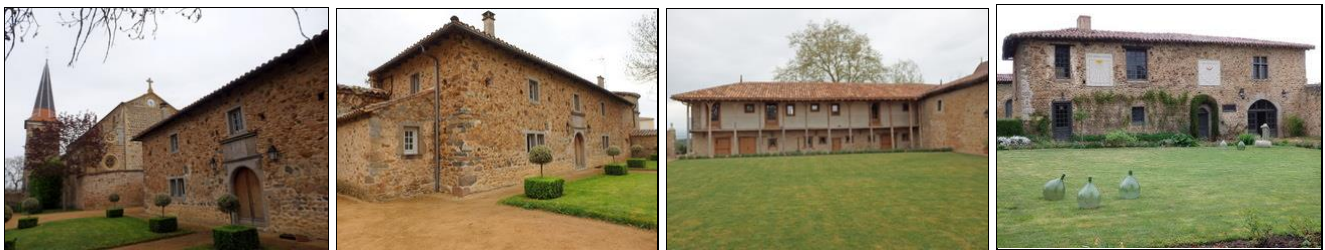
Château de St Marcel de Félines, l'église et les communs
